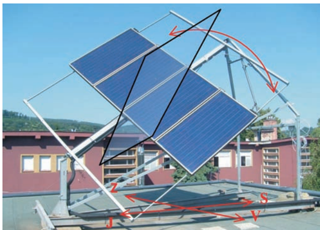
Obr. 1 Solárne panely nainštalované na konštrukcii natáčajúcej sa po dráhe kopírujúcej ekliptiku slnka
